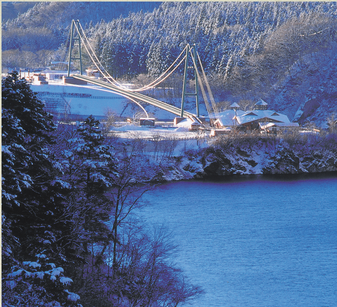
全長320m本州一長い無補剛桁歩道吊橋のもみじ谷大吊橋
